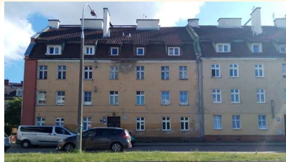
Фото 20: Щільна блокована забудова створює високий ризик поширення вогню через спільний підпокрівельний простір між суміжними секціями. На фото представлено житлові будинки рядової забудови. Специфіка об'єкта ускладнює проведення розвідки з тильної сторони, де можуть бути виявлені додаткові осередки горіння або шляхи поширення вогню. Доступ до кожної секції зазвичай обмежений лише однією входною групою. Особлива увага: на балконі другої секції праворуч відсутнє перильне огороження, що створює пряму загрозу падіння особового складу з висоти під час проведення рятувальних робіт або подачі стволів.
