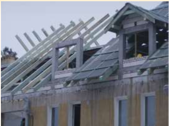
Фото 4: Скатні дахи приховують значні закриті простори (горища), де може відбуватися неконтрольоване поширення диму або приховане горіння. Світлину зроблено під час надбудови додаткового поверху будівлі.
