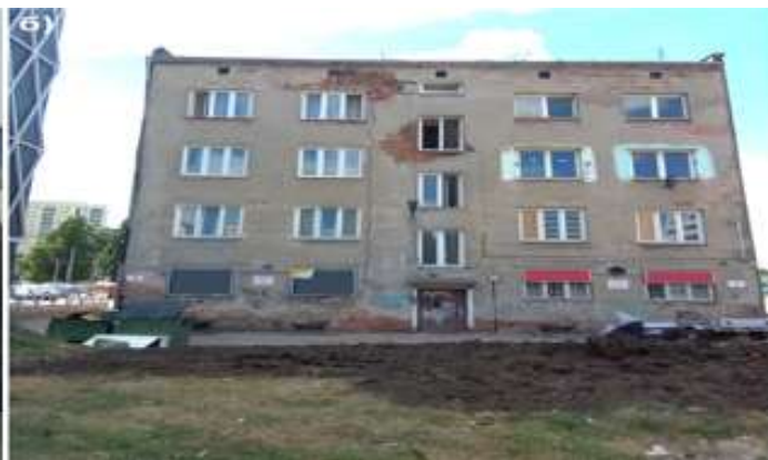
Фото 20: Щільна блокована забудова створює високий ризик поширення вогню через спільний підпокрівельний простір між суміжними секціями. На фото представлено житлові будинки рядової забудови. Специфіка об'єкта ускладнює проведення розвідки з тильної сторони, де можуть бути виявлені додаткові осередки горіння або шляхи поширення вогню. Доступ до кожної секції зазвичай обмежений лише однією входною групою. Особлива увага: на балконі другої секції праворуч відсутнє перильне огороження, що створює пряму загрозу падіння особового складу з висоти під час проведення рятувальних робіт або подачі стволів.
