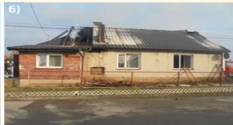
Фото 43 а–б: Зміна забарвлення фарби на даху може бути ознакою місця наявного вогню у будівлі. Деколи, конструкція даху може ускладнювати пошук справжнього місця горіння. Використання тепловізора та старанність у подачі води у відповідне місце збільшує ефективність і зменшує збитки.
