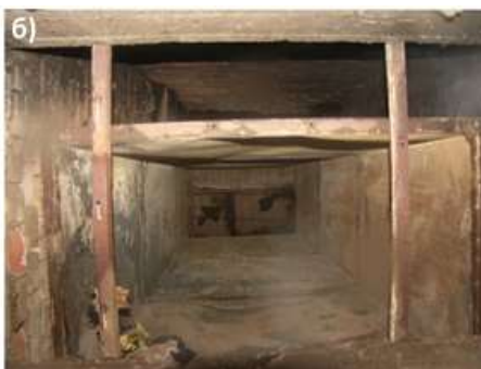
Фото 39 а–б: Початок вентиляційного каналу, через який нагріті продукти згорання прямували у концертний зал. Велика кількість щілин була причиною одночасної появи задимлення у різних місцях, часто віддалених від вогнища пожежі.
