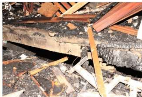
Фото 39 а–б: Початок вентиляційного каналу, через який нагріті продукти згорання прямували у концертний зал. Велика кількість щілин була причиною одночасної появи задимлення у різних місцях, часто віддалених від вогнища пожежі.
