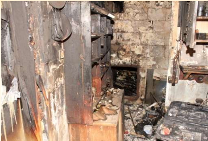
Фото 37: Ще раз вигляд приміщення, у якому виникла пожежа. Видно ті горючі матеріали, які залишилися прямо за стіною, а також інші отвори, якими дим розпочав переміщення у віддалені об'єми будинку. Значна густина пожежної навантаги сприяла підсиленню продукування палив у газовому агрегатному стані.
