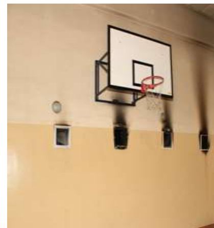
Фото 35: Приміщення, у якому виникла пожежа. У стіні навпроти видно вентиляційний отвір, який веде у зал для гімнастики. По праву сторону, у низу і на горі видно отвори, через які проходив дим у замуrowаний простір, в якому також наскладано різні види горючих матеріалів. У приміщенні за стіною праворуч знаходився початок вентиляційного каналу, вихід якого був розташований під глядацькою частиною концертного залу на два поверхи вище.
