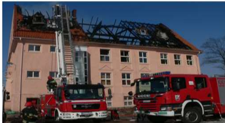
Фото 5: Наслідки пожежі горючих конструкцій даху в будівлі гімназії у м. Вельбарк (Щиценський повіт, Польща), 2–3 березня 2011 року.
