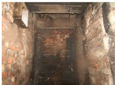
Фото 39 а–б: Початок вентиляційного каналу, через який нагріті продукти згорання прямували у концертний зал. Велика кількість щілин була причиною одночасної появи задимлення у різних місцях, часто віддалених від вогнища пожежі.
