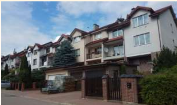
Фото 20: Щільна блокована забудова створює високий ризик поширення вогню через спільний підпокрівельний простір між суміжними секціями. На фото представлено житлові будинки рядової забудови. Специфіка об'єкта ускладнює проведення розвідки з тильної сторони, де можуть бути виявлені додаткові осередки горіння або шляхи поширення вогню. Доступ до кожної секції зазвичай обмежений лише однією входною групою. Особлива увага: на балконі другої секції праворуч відсутнє перильне огороження, що створює пряму загрозу падіння особового складу з висоти під час проведення рятувальних робіт або подачі стволів.
