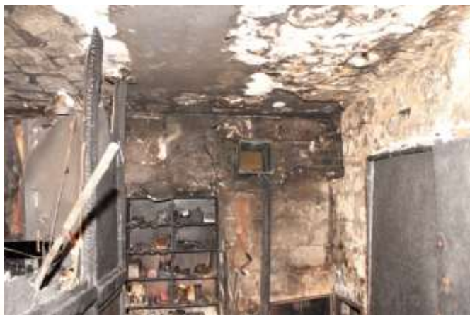
Фото 35: Приміщення, у якому виникла пожежа. У стіні навпроти видно вентиляційний отвір, який веде у зал для гімнастики. По праву сторону, у низу і на горі видно отвори, через які проходив дим у замуrowаний простір, в якому також наскладано різні види горючих матеріалів. У приміщенні за стіною праворуч знаходився початок вентиляційного каналу, вихід якого був розташований під глядацькою частиною концертного залу на два поверхи вище.
