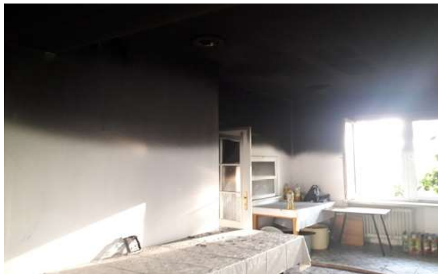
Фото 32: Фотографія після пожежі у квартирі. Видимий на стіні слід кіптяви вказує на висоту розташування нейтральної площини. У цій пожежі, пожежники, які перебували при підлозі не мали обмеженої димом видимості. Рівень задимлення одночасно давав змогу витоку диму через вікно та прихід через нього повітря всередину (двосторонній потік). Велика висота лінії кіптяви вказує на швидку локалізацію ситуації пожежниками
