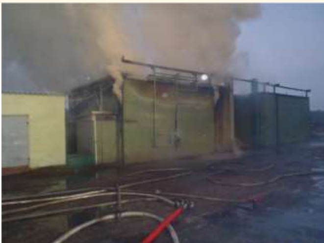
Фото 42: Зміна забарвлення на стіні виразно вказує на наявність значної кількості тепла у будівлі.
